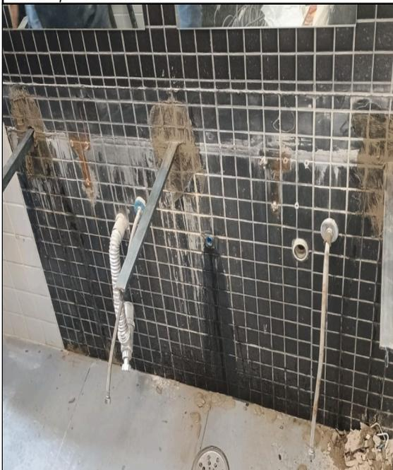
**FOTO 68:** Manutenção corretiva do conjunto de pias e bancada do sanitário do 3º pavimento.
