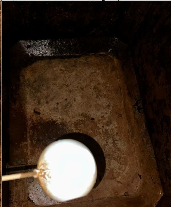
**FOTO 33:** Higienização dos reservatórios superiores e inferiores de água potável.
