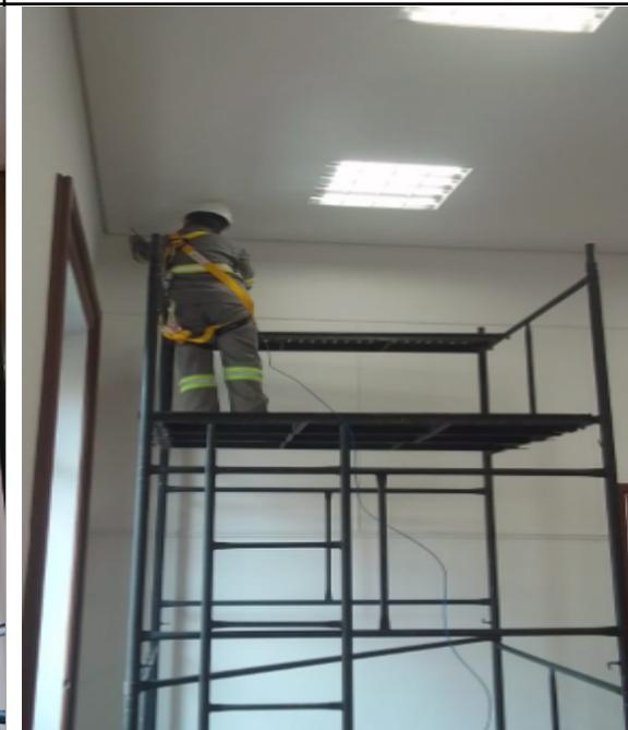
**FOTO 08:** Iniciado implantação do sistema de CFTV de rede wireless
