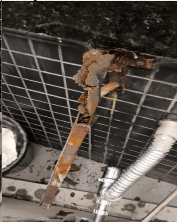
**FOTO 65:** Manutenção corretiva do conjunto de pias e bancada do sanitário do 3º pavimento.
