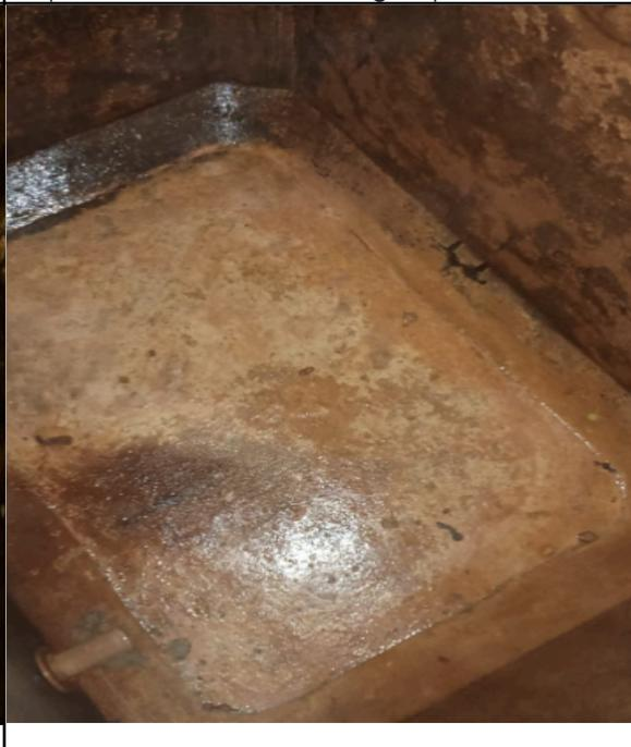
**FOTO 31:** Higienização dos reservatórios superiores e inferiores de água potável.
